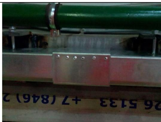
После установки всех кронштейнов подвешивается рельс. Первый рельс, с установленным кронштейном ролика груза (4), выступает на 100 мм за проём на стороне примыкания (закрытия).
