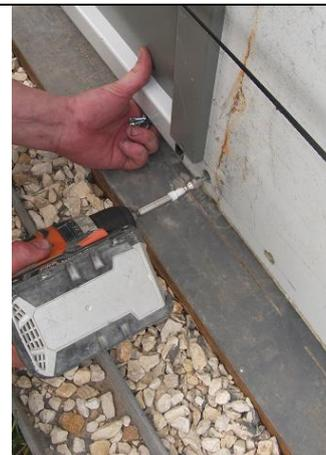
Допустимый зазор между полом и полотном ворот - 10...20 мм. Данный зазор необходим для беспрепятственного закрывания/открывания ворот. При пожаре терморасширяющаяся лента, установленная на нижнем профиле полотна ворот, заполняет его.
