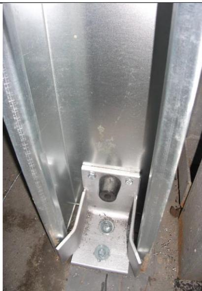
Для возможности регулировки по высоте карман примыкания (12) поставляется с избыточной высотой. Измерьте расстояние от верхней кромки рельса до пола и, если необходимо, укоротите карман примыкания снизу. Боковые стенки кармана примыкания должны прилегать к рельсу.
